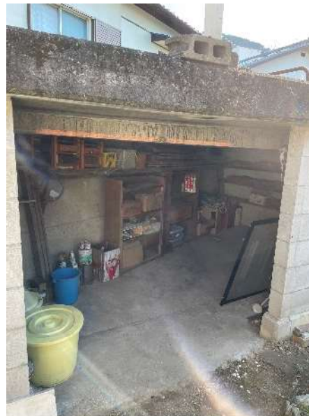
駐車場下倉庫
